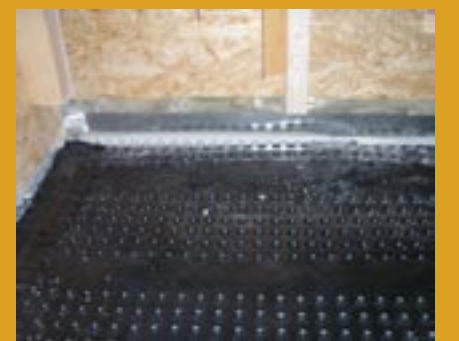
Olika delar kopplas ihop med Stuck & Seal då golven lades i olika etapper.
