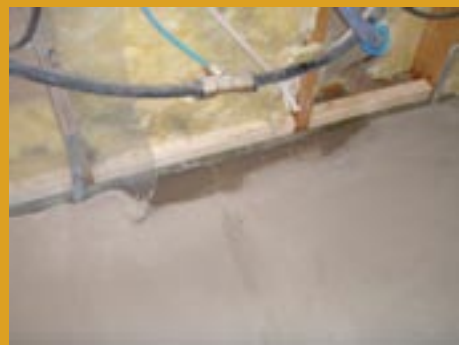
På syllar skruvades regler som syllkanalerna skruvades fast i.
