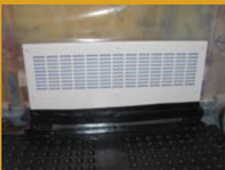
Väggdon monterades enligt dimensionering. Väggdonen tätas mot kanal eller matta så att all luft transporteras genom filtret.
