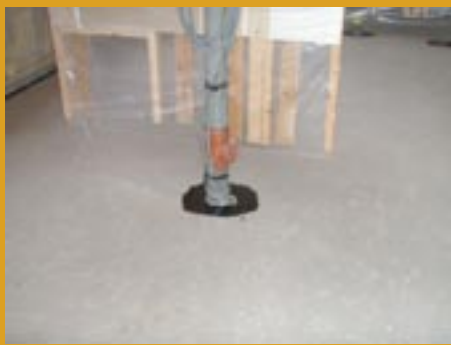
För vidhäftning primades ytorna längs med ytterkanterna och runt genomföringar, för vidhäftning vid tätning.
