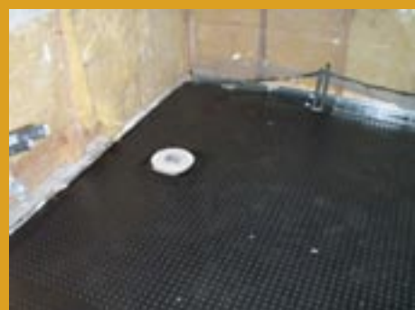
Längs med ytterkanterna som inte var yttervägg tätades systemet med Fogband och Stuck & Seal.
