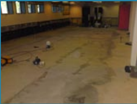
Golven i båda lokalerna spacklades jämna innan Opti Vent systemet installerades.
