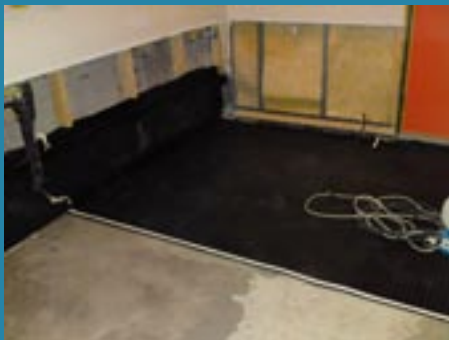
Opti Vent systemet är sammankopplat mellan vägg och golv.
