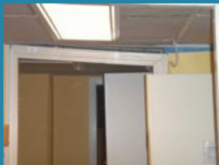
Alla väggar hade lämnats frihängande, under installationen klossades väggarna upp med plastklossar. Alla väggar är tillrättade och sitter fast.
