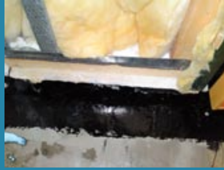
Längs alla väggar och ca 50 cm upp på alla ytterväggar primades ca 10 cm brett, som underlag/vidhäftning för fogband och Stick & Seal tätning.
