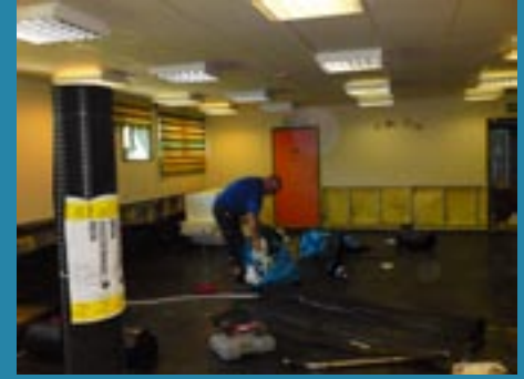
Black Line rullades och tätades i skarvarna med skarvband.
